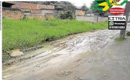
Rua Formosa, na Vila Pauline, atolada em lama e abandono
